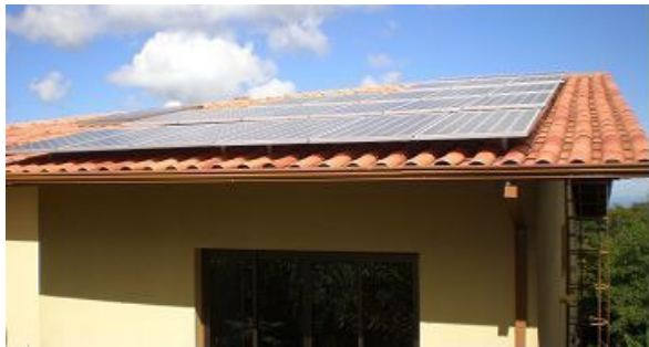
Residência com energia solar fotovoltaica – Nova Lima - MG
