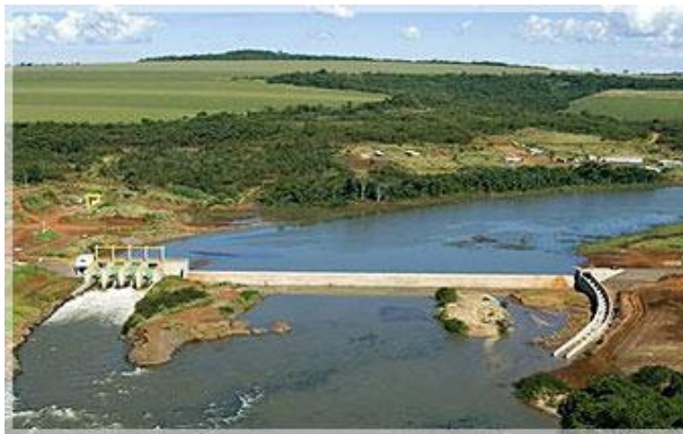
Foto 02 - PCH Jataí - 30 MW Jataí - GO
