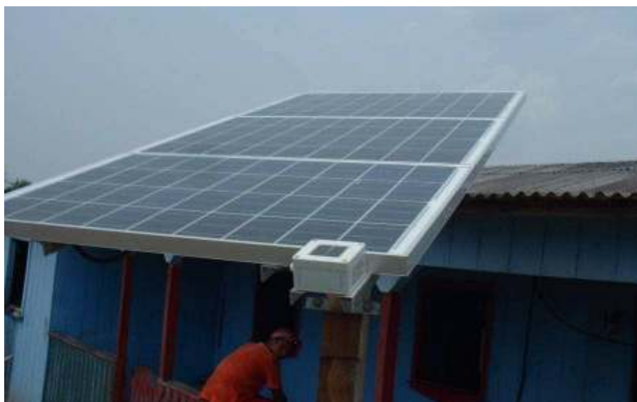
Figura 16 Painel fotovoltaico e sensor de radiação acoplado Fonte: ELETROACRE (2008)
