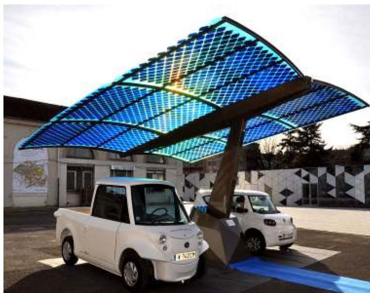
Figura 6 Estação autônoma de recarga de veículos elétricos alimentada por módulos fotovoltaicos
