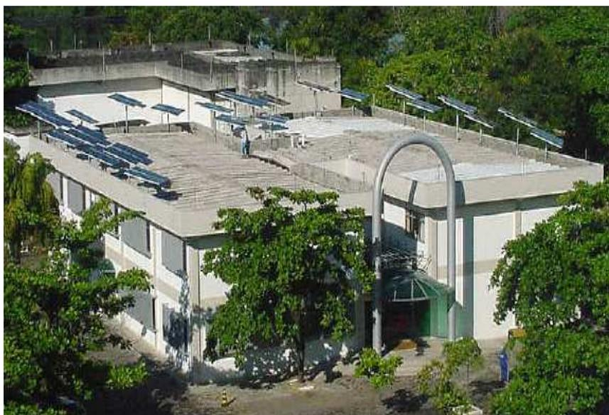
**Figura 27** – Gerador FVCR de 16,32 kWp, instalado no Cepel
