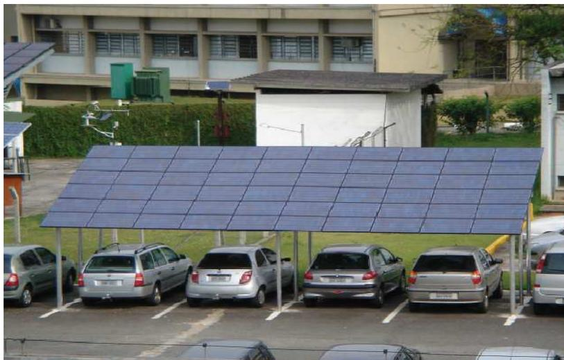
**Figura 30** – Sistema de 3 kWp no estacionamento do IEE\_USP
