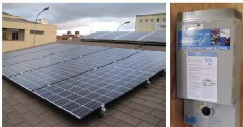
**Figura 9** – Painel FV e o inversor do SFVCR.
