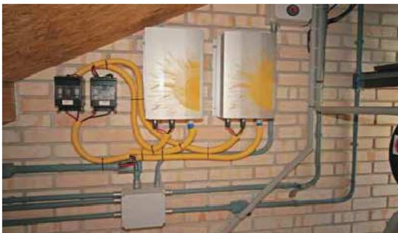
**Figura 22** - Inversores e chaves seccionadoras do SFV
