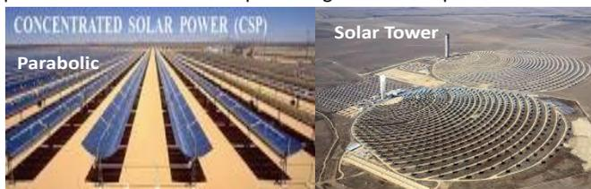
O custo da instalação CSP é geralmente maior do que o custo da FV. Os preços das instalações estão entre R\$ 350,00 e R\$ 650,00/MWh, a depender da tecnologia e das horas de armazenamento. Para 2020, se espera que os custos possam diminuir de 30% a 50%.
