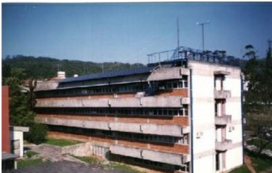
Figura 16 – Módulos instalados no prédio do Departamento de Engenharia Mecânica da UFSC (Fonte: LABSOLAR - UFSC)
