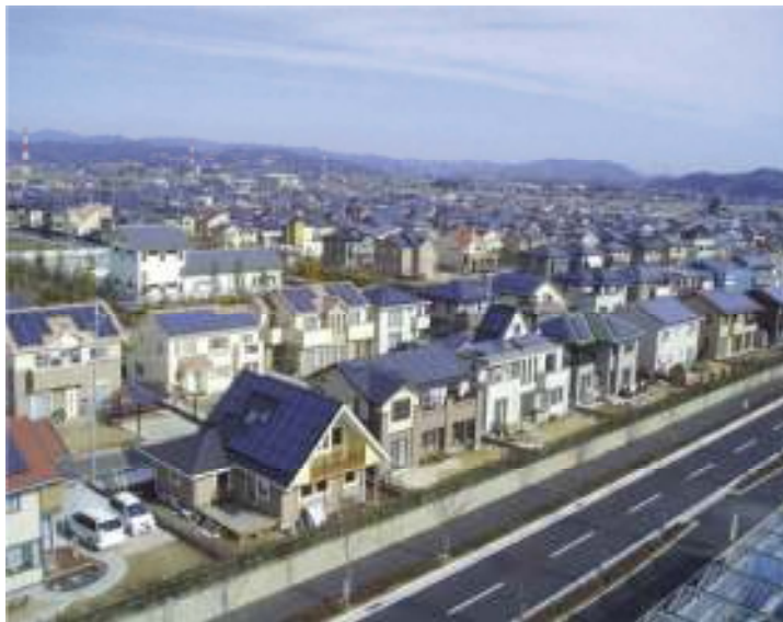
FIGURA 4 - Painel solar fotovoltaico
