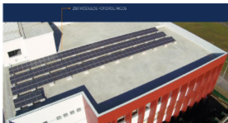
Figura 2 – Usina Fotovoltaica do UNIPAM
