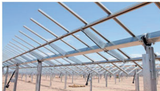
Figura 21. Estrutura metálica de um módulo fotovoltaico
